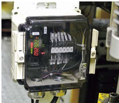
センサーアンプ取付け例
